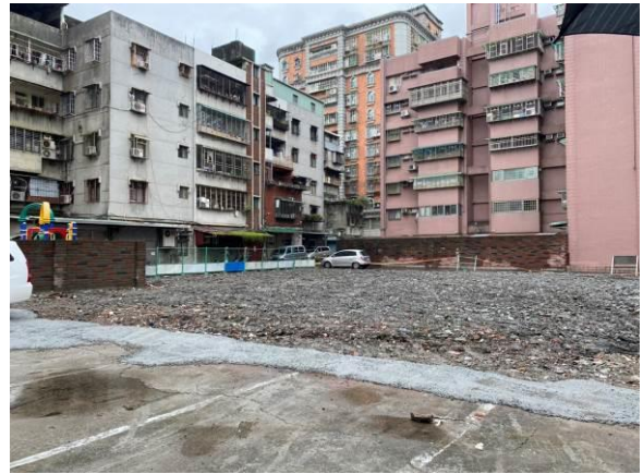
地上物拆除後現況 (2)
