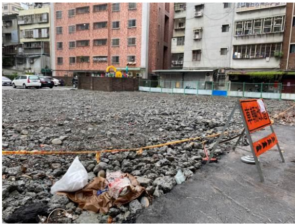
地上物拆除後現況 (3)
