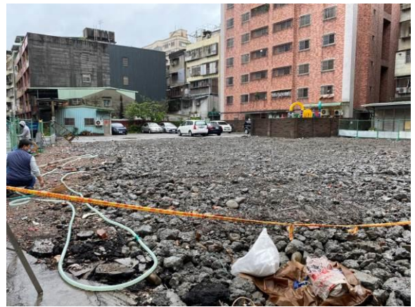
地上物拆除後現況 (4)
