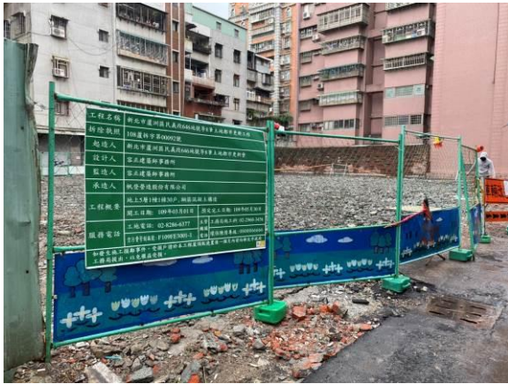
地上物拆除後現況 (1)
